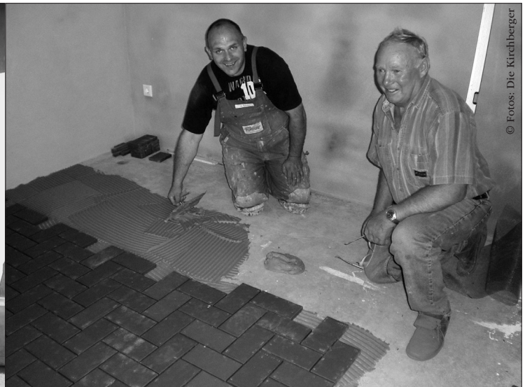
Trittfest: Mit dem neuen Fußbodenbelag wurde im Bahnhäuschen der Grund für alles Weitere gelegt
