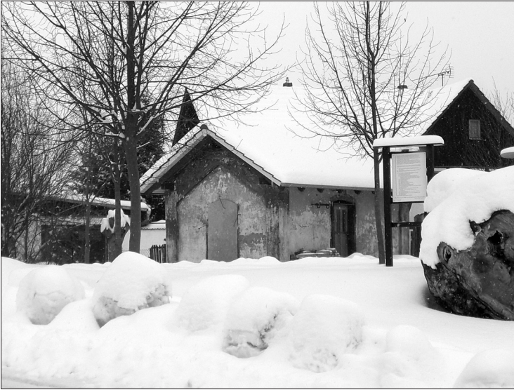
Verschneit: Das alte Bahnhäuschen vor den Umbauarbeiten im letzten Winter
