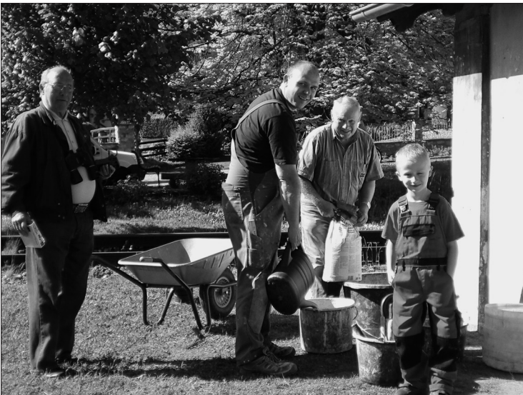
Familieneinsatz: Bei den Sanierungsarbeiten packten alle Generationen der Kirchbergbewohner mit an
