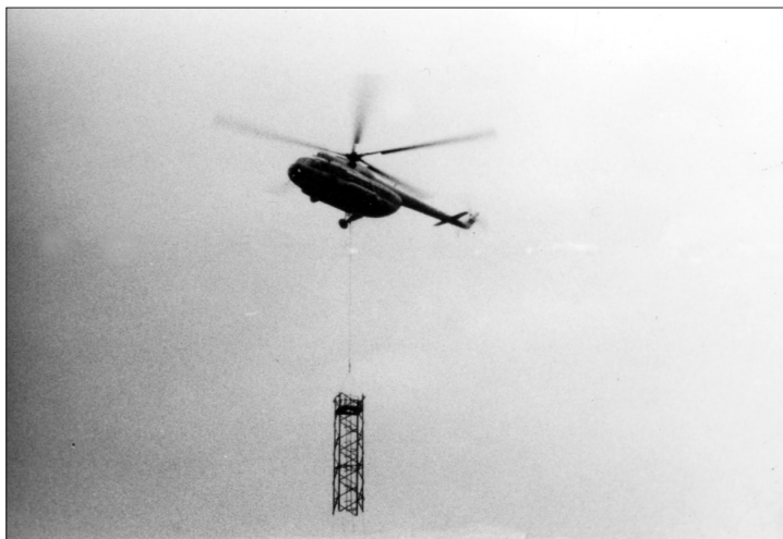
Transport der Stahlkonstruktion
