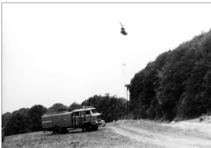
Montage des Gittermastes Tanklöschfahrzeug der FFW Mühlhausen TLF16 – W50
