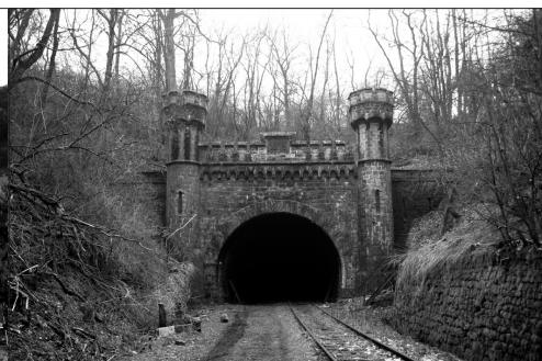
Das Portal des Küllestedter Tunnels, nur ein Beispiel entlang der Strecke
