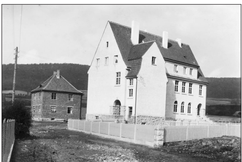
Neue Schule - erbaut 1929/30
